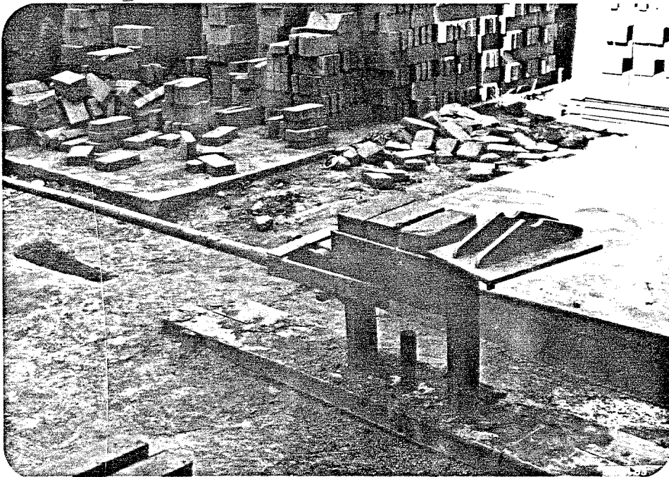
Equipamento utilizado para a moldagem dos tijolos.
