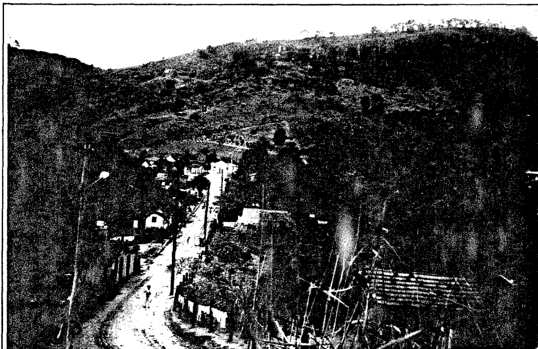
Santo Afonso - vista geral
