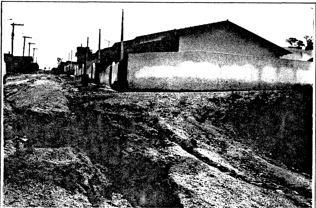
Loteamento Gadioli - falta de infra-estrutura básica
