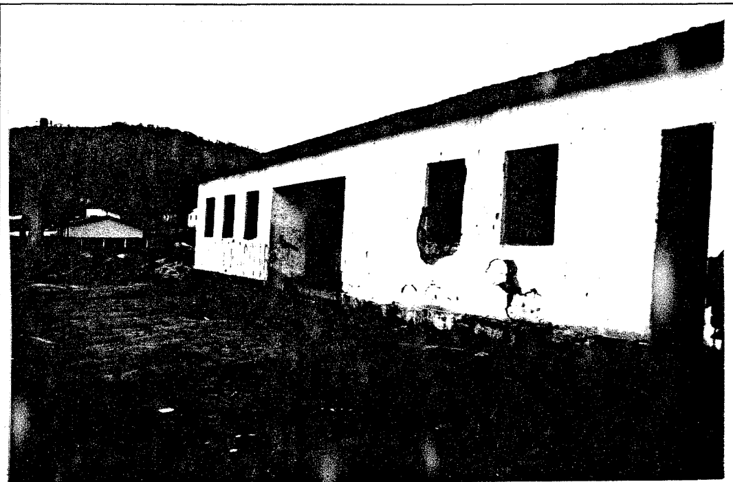
Prédio escolar abandonado e depredado
