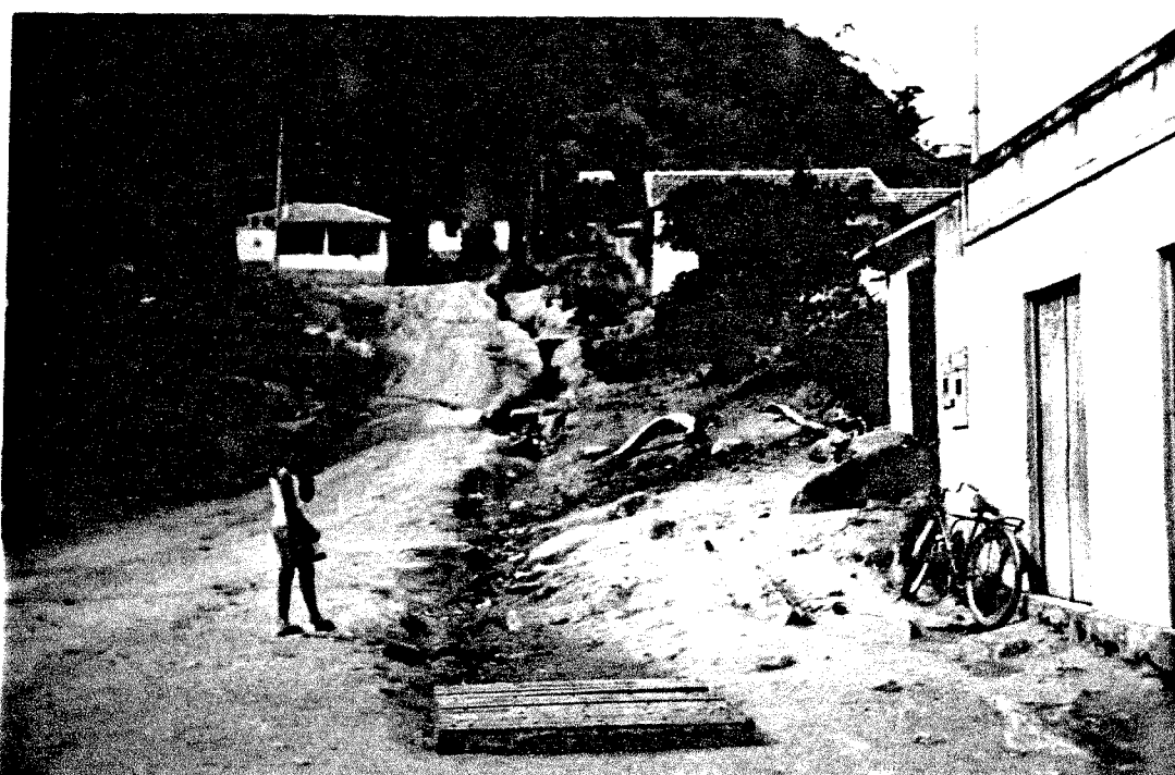
Falta de sistema coletor deixa frestas nas vias urbanas
