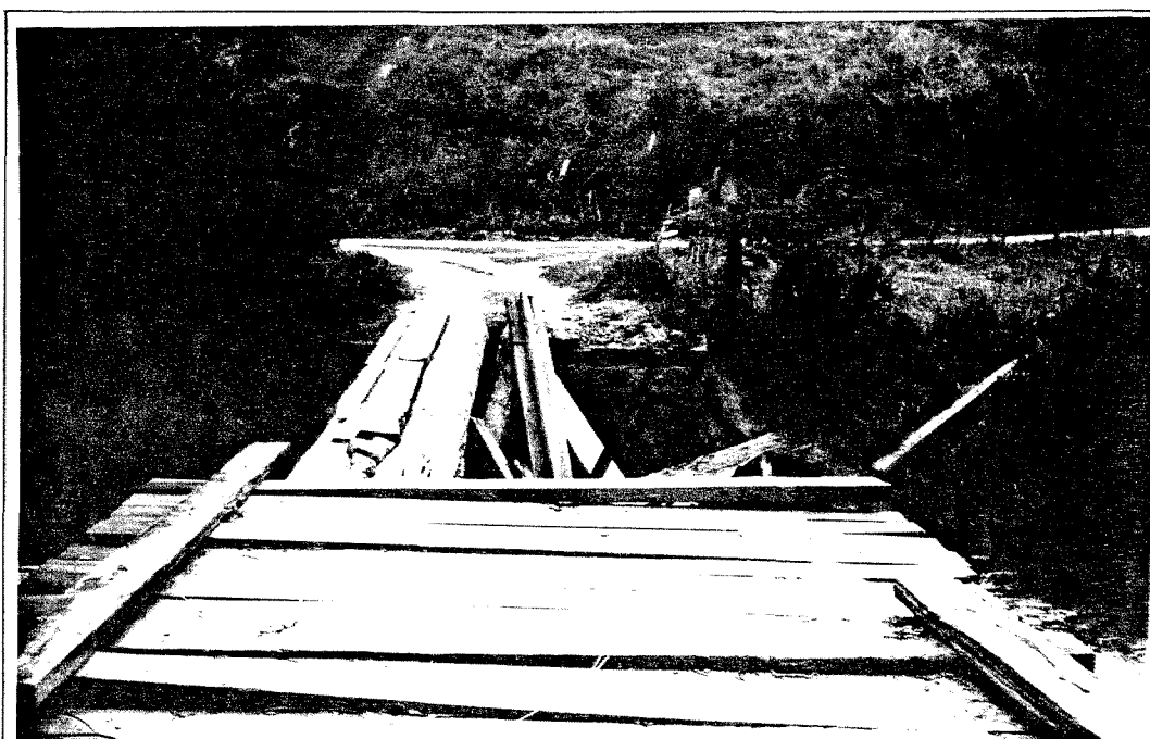
Estrada de Água Branca x Córrego das Flores Ponte de madeira em ruínas
