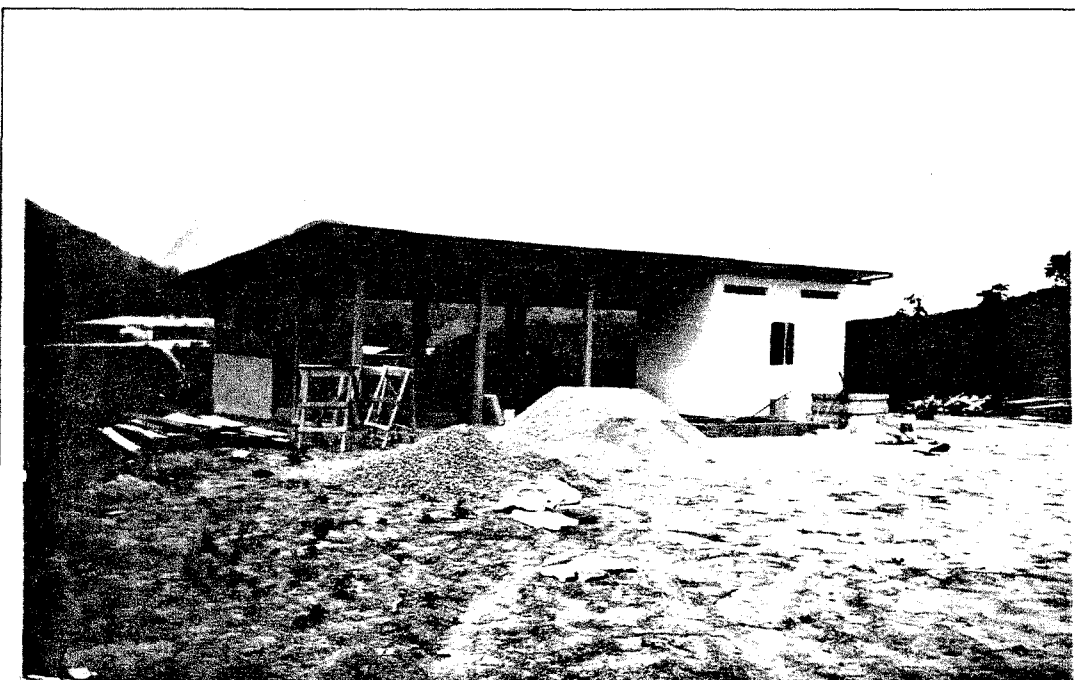
POCILGA DO CIER - em construção
