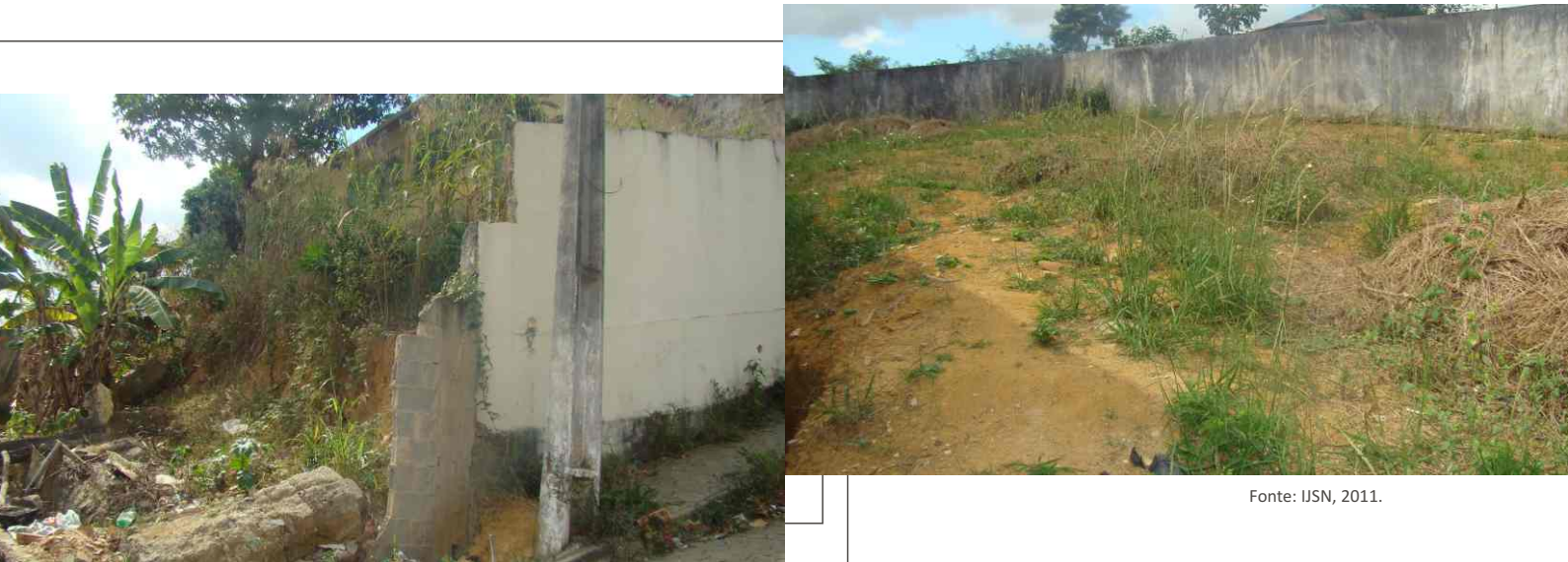
Figura 14 – Escolas com Muros Baixos, Quebrados e com Espaços Mal Cuidados nos Bairros Nova Bethânia e Areinha – 2011
