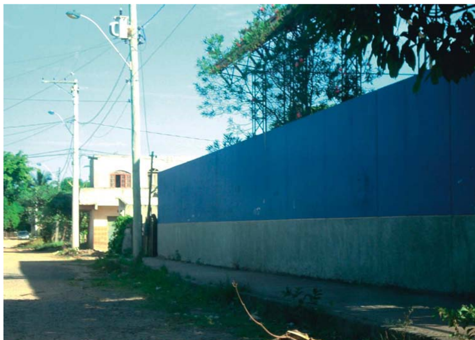
Figura 15 – Muro com mais de 2 metros de altura na escola UMEF Alger Ribeiro Bossóis, em Cidade da Barra 2011
