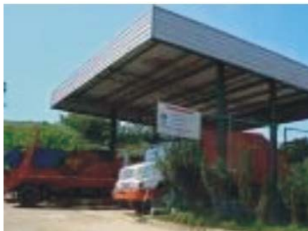
Figura 10: Estação de Transbordo
