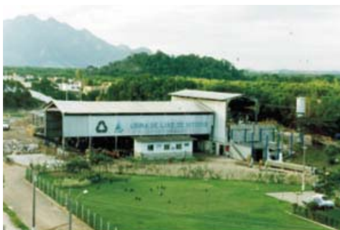
Figura 24: Usina de Triagem e Compostagem
