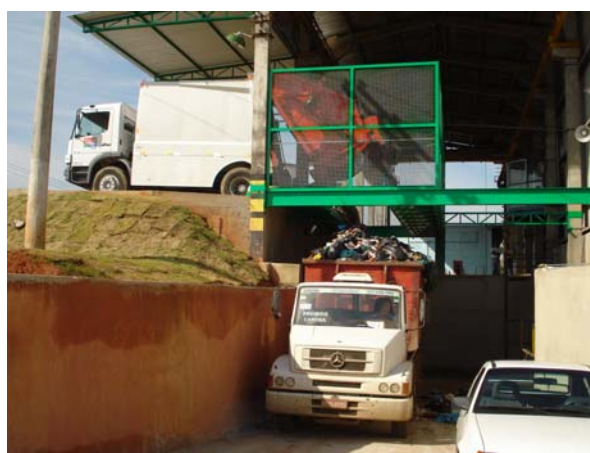
Figura 9: Transbordo de resíduos para transportá-los ao aterro sanitário.
