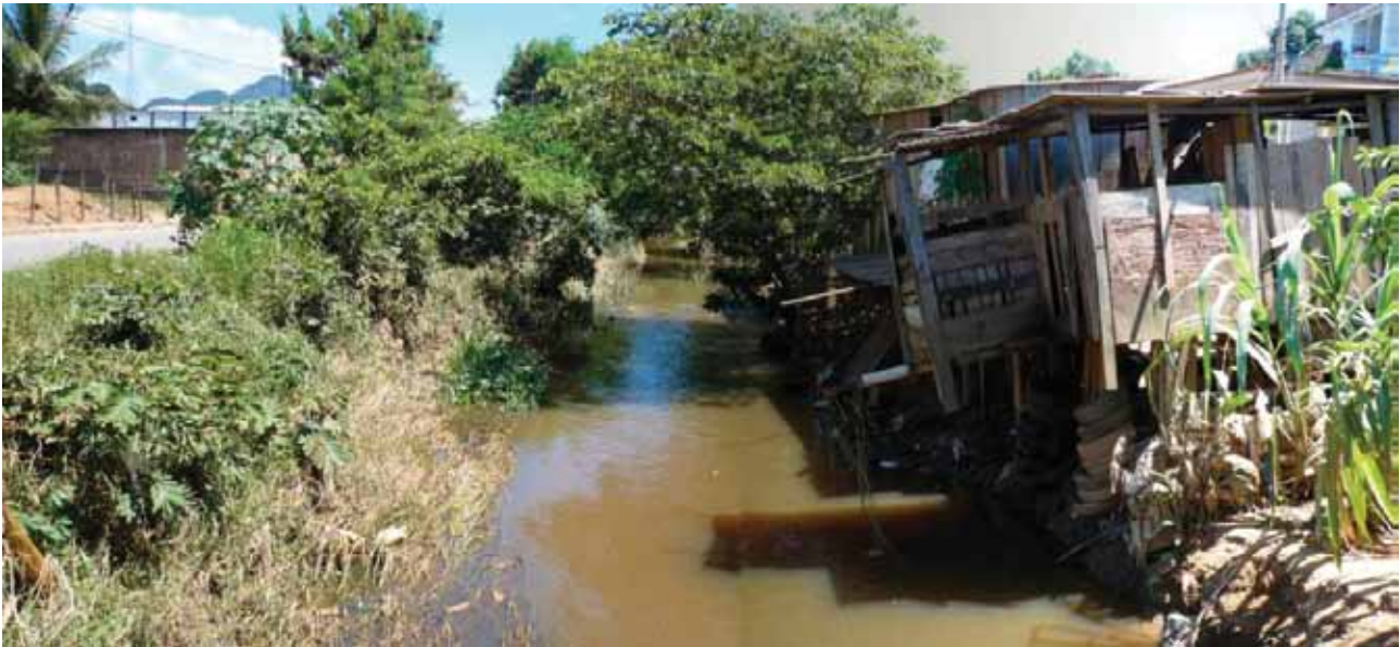
Ocupação irregular das margens do rio Formate
