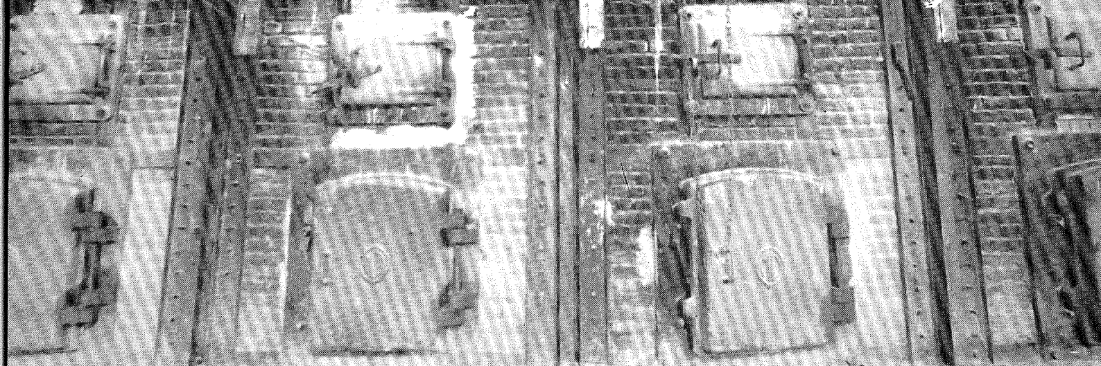
Fornos para queima do bagaço de cana na Usina de Paineiras.
