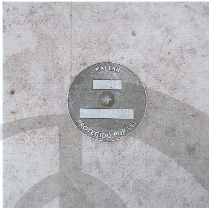
Figura 03 – Detalhe da chapa metálica com inscrições do marco de concreto.
