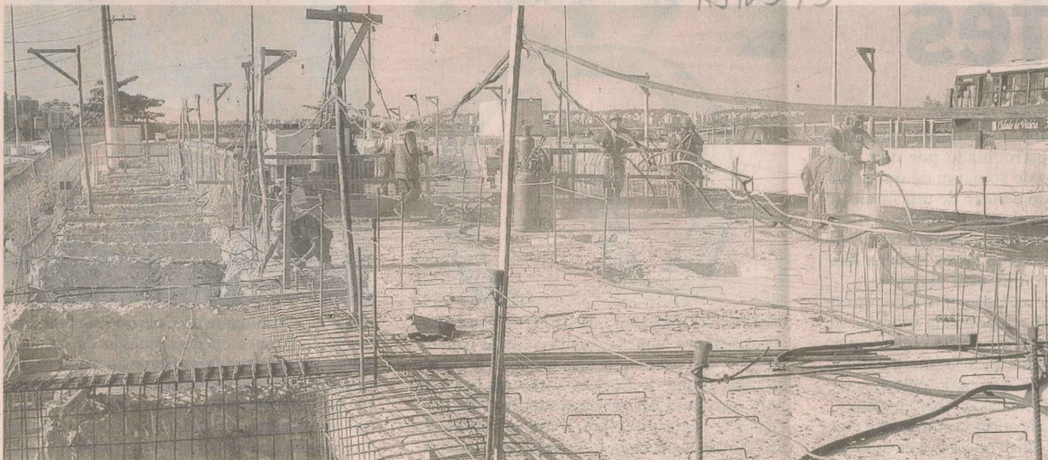
MAIS PESO. Com a nova estrutura a ponte passará a suportar 45 toneladas, 15 a mais do que quando foi projetada. FOTO: CHICO GUEDES
