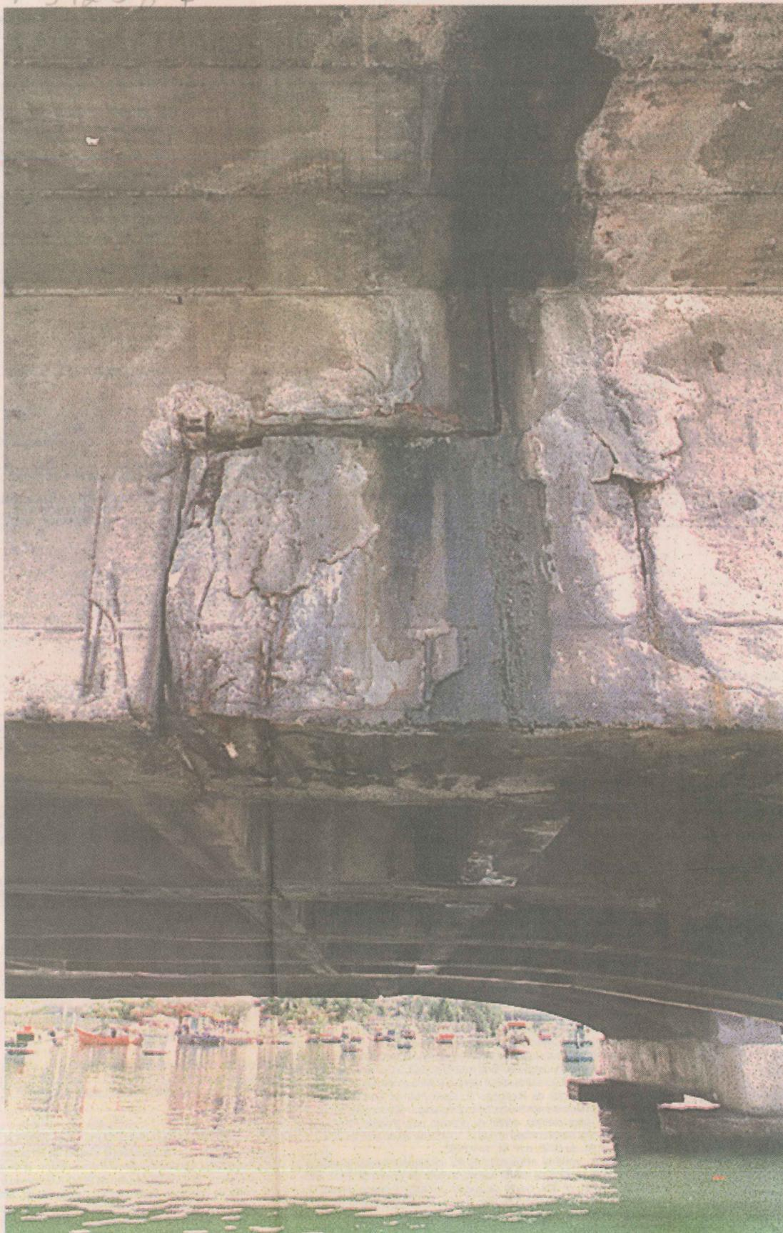
**CONSTATAÇÃO.** Em matéria de 2004, A GAZETA constatou que ferragens estavam corroídas e à mostra, além de a estrutura apresentar trincas e concreto solto em alguns trechos. FOTO: GILDO LOYOLA - 12/7/2004
