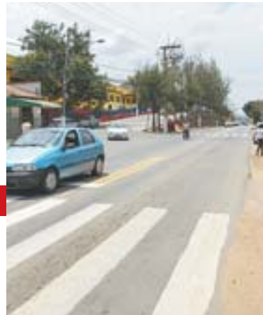
RODOVIA José Sette: melhorias
