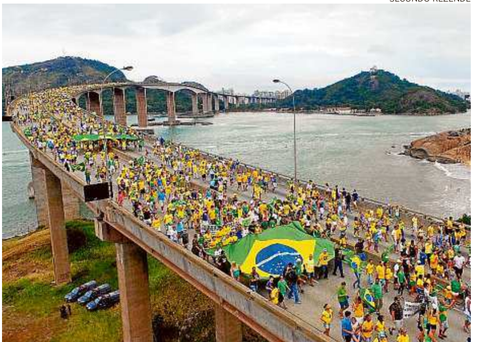
Visão aérea da Terceira Ponte durante travessia de manifestantes para Vitória
