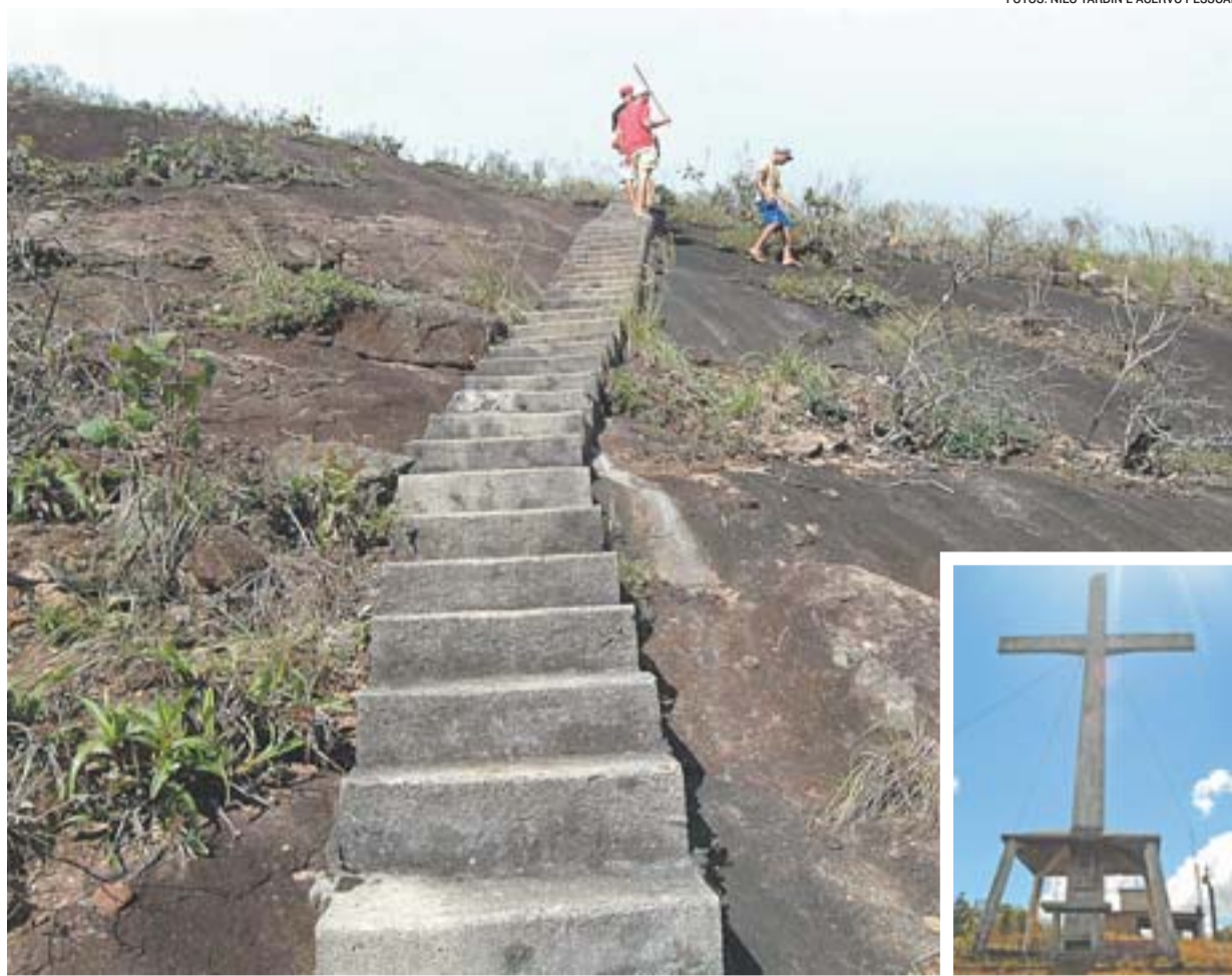
ESCADARIA DA SANTA CRUZ DE ALTO LIBERDADE: próxima peregrinação ao local vai acontecer no dia 30 de abril
