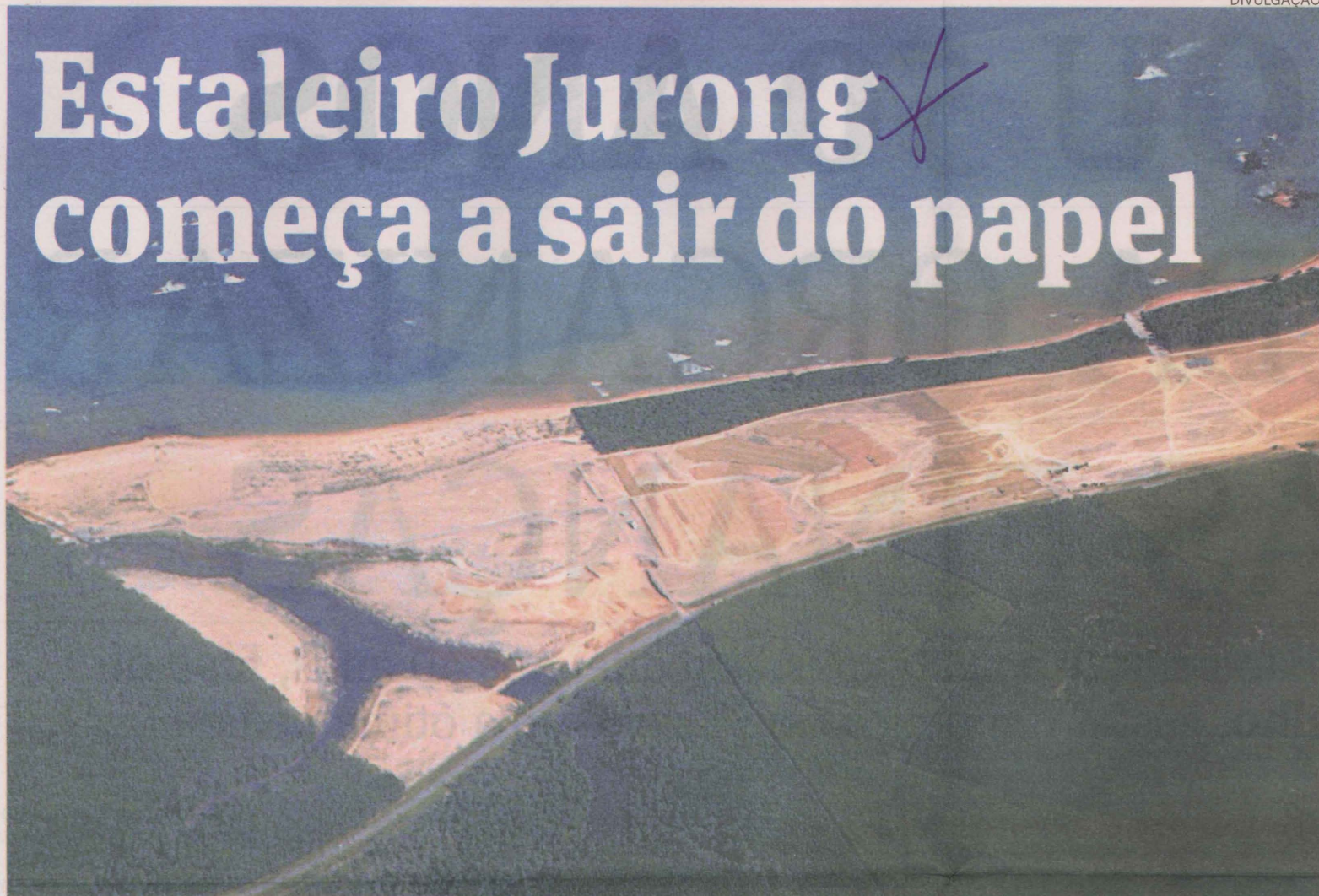
Canteiro de obras, que terá um espaço específico para o depósito de pedras, ocupará área de 30 mil metros quadrados
