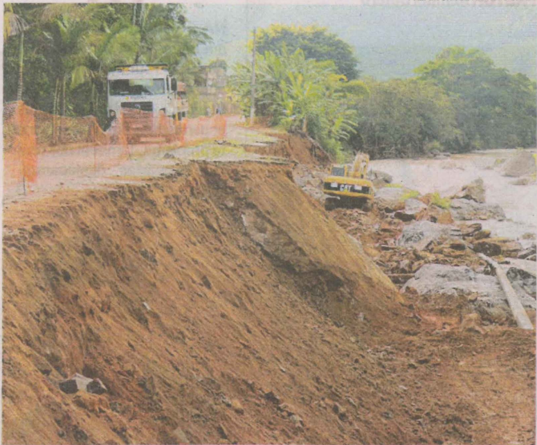
OBRAS em trecho da ES-146: muro de contenção será construído
