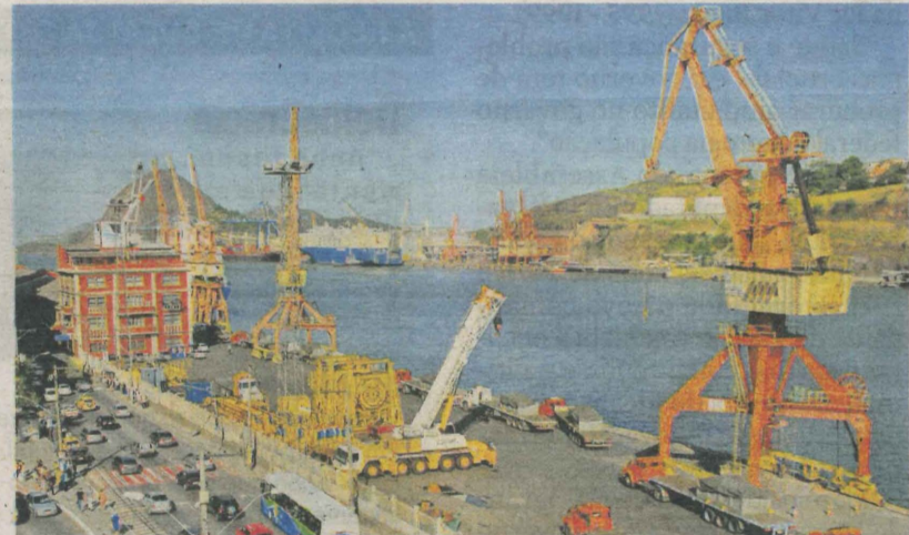
PORTO DE VITÓRIA, cujas obras de dragagem foram paralisadas pelo TCU
