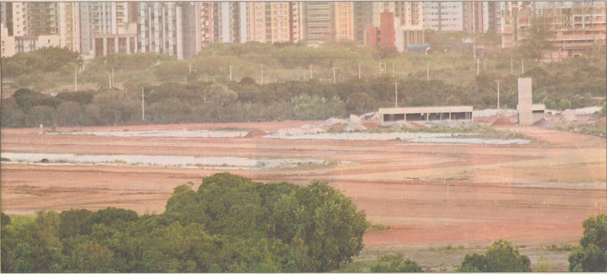
As obras de modernização do aeroporto de Vitória vão sofrer novo atraso e poderão durar mais um ano, com o processo de licitação previsto pelo governo
