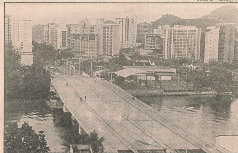
A ponte vai reduzir em 20% o fluxo de veículos na avenida
