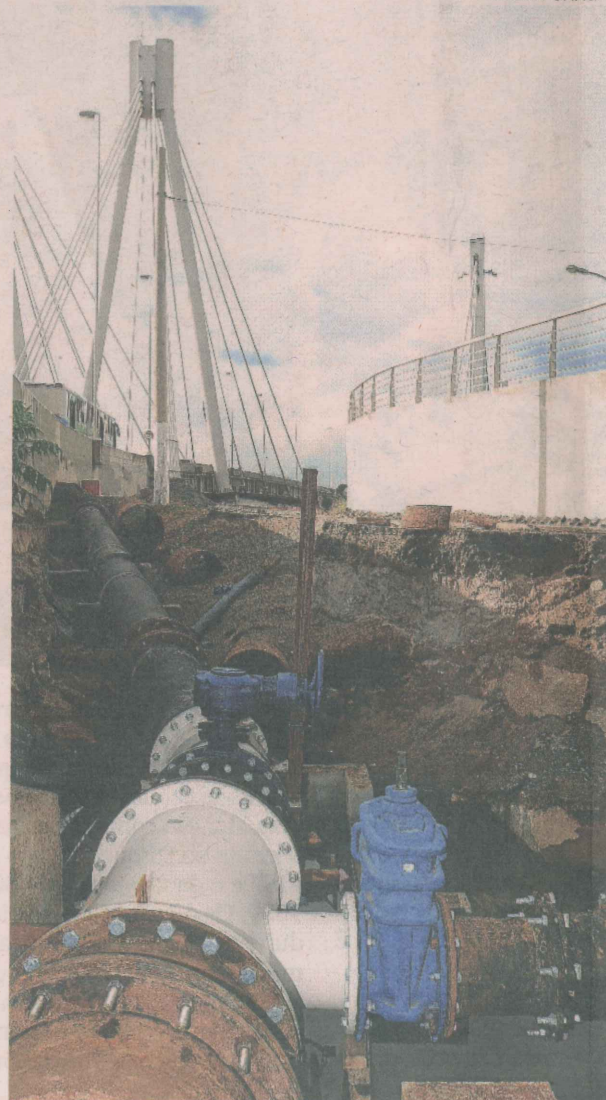
A Cesan já terminou uma adutora no local
