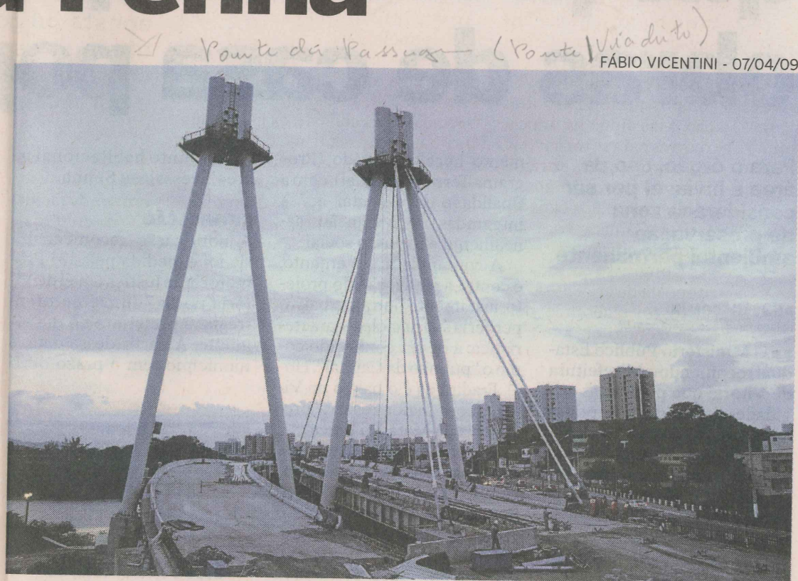
CONCLUSÃO. A nova Ponte da Passagem deve ficar pronta no mês de julho
