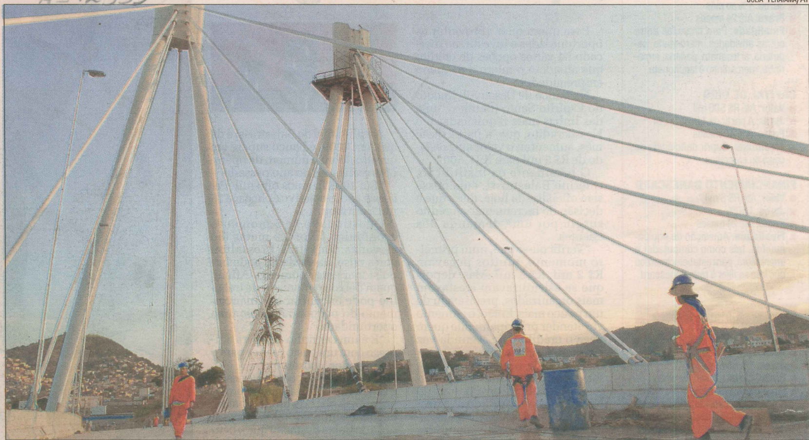
Operários fazem os últimos ajustes na nova Ponte da Passagem, em Vitória, que deve ser liberada daqui a um mês
