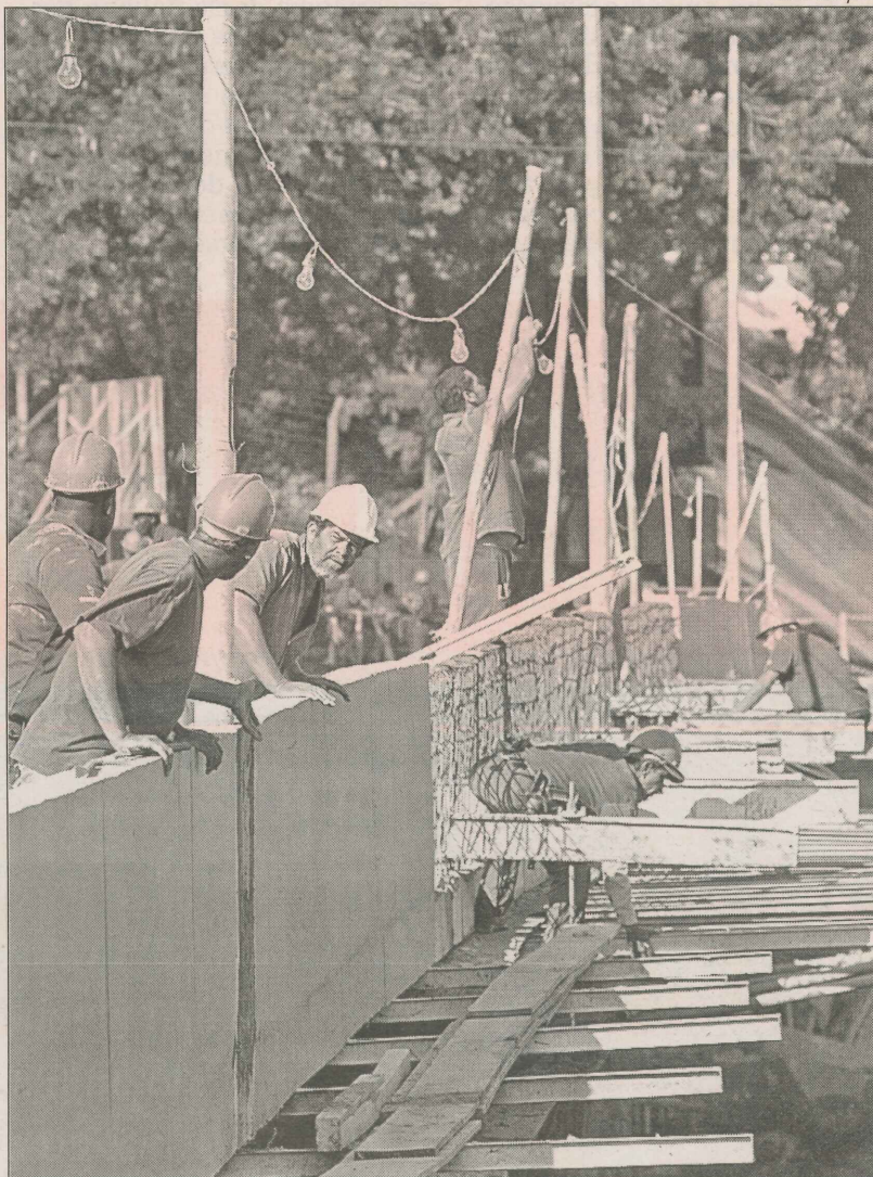
Trabalhadores fazem acertos na ponte para liberação do trânsito
