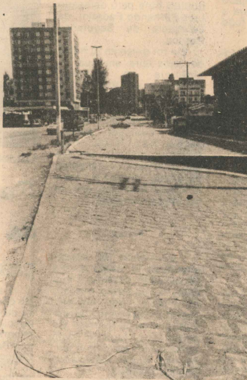
Com o novo projeto, parte da avenida fica como estacionamento
