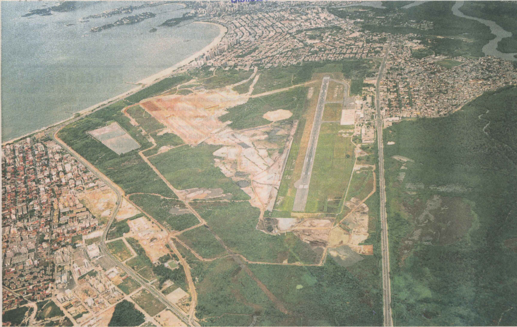
AS OBRAS de reforma e ampliação do aeroporto de Vitória, que estão paralisadas desde 2008, estão passando pela fiscalização de um instituto paulista
