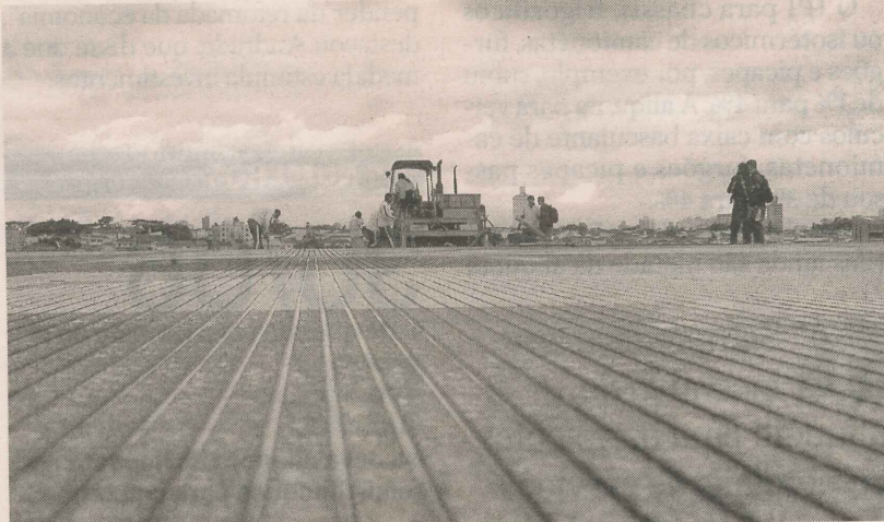
RANHURAS NO ASFALTO: medida ajuda a evitar derrapagens
