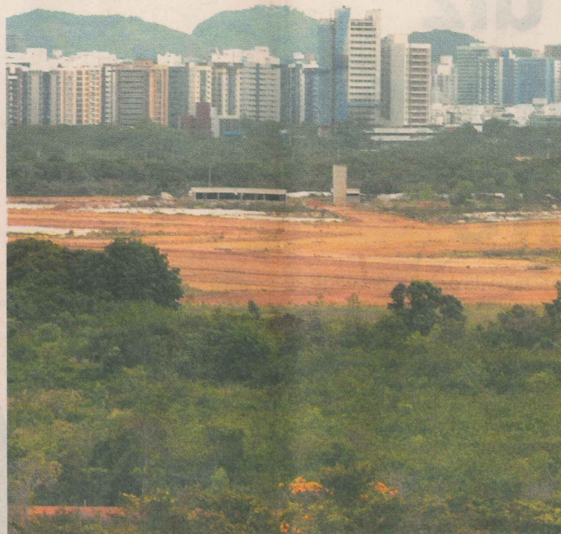
OBRAS do aeroporto de Vitória: conclusão prevista só para 2013
