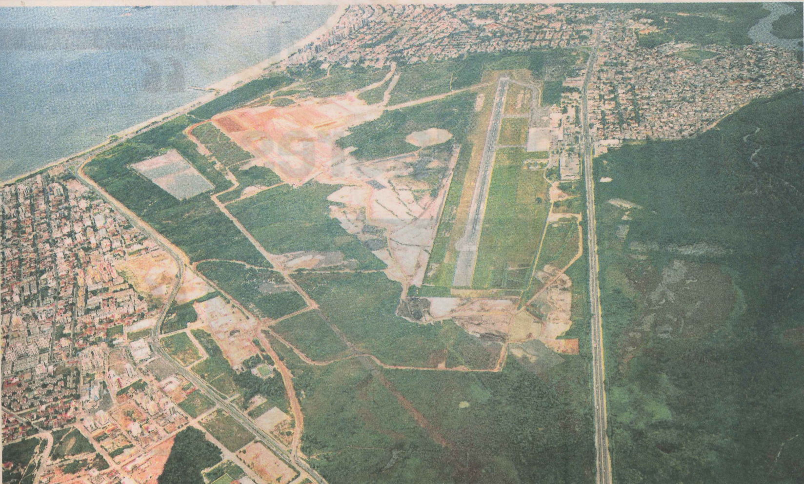
VISTA AÉREA DO AEROPORTO: obras de ampliação serão feitas em duas etapas, e a previsão é de que sejam concluídas até junho de 2011
