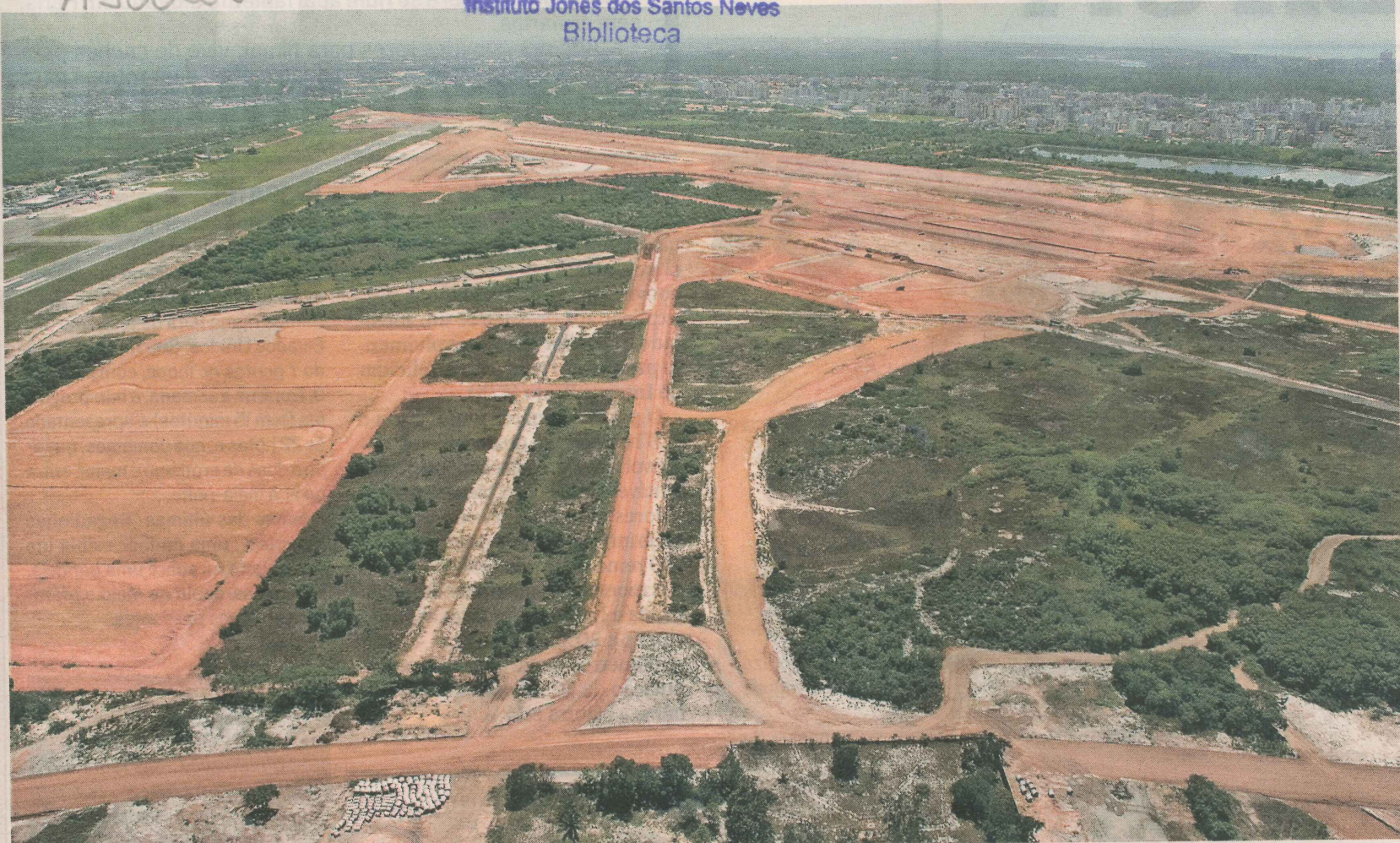
VISTA AÉREA DAS OBRAS DE AMPLIAÇÃO do aeroporto de Vitória: rescisão entre consórcio responsável pelas obras e a Infraero foi feita em maio
