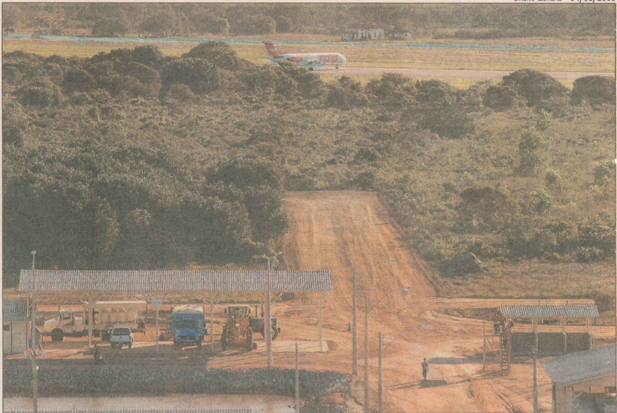
Início das obras no aeroporto, que serão retomadas neste ano, após nova licitação
