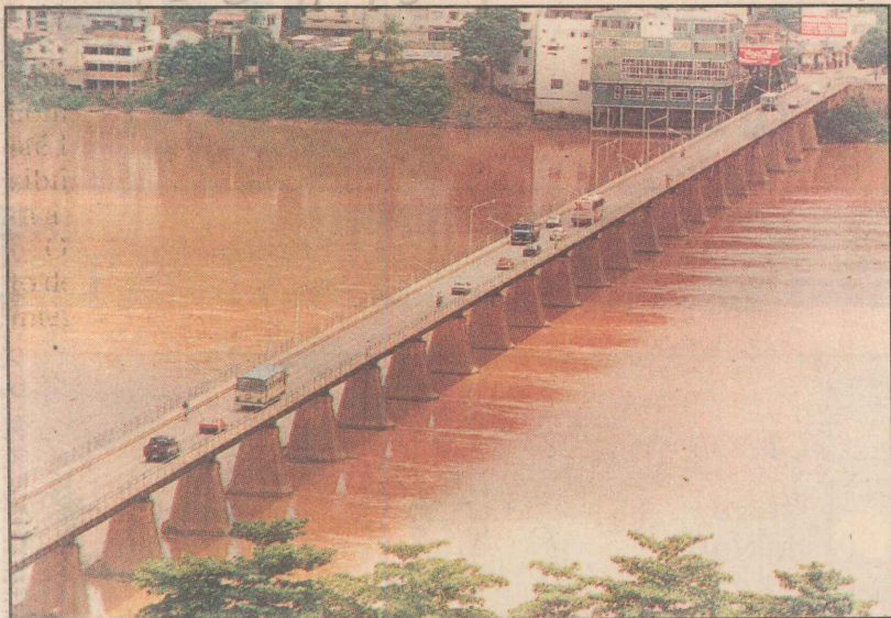
O trânsito sobrecarrega a Ponte Florentino Avidos, construída em 1928
