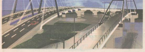
MODERNIDADE. A nova Ponte da Passagem terá mais uma pista de cada lado, e terá 270 metros de comprimento. A passagem de pedestres e ciclistas vai acontecer numa passarela, construída ao lado. Feita em estrutura metálica e mais alta, a ponte vai permitir a navegação de pequenas embarcações. O custo total da obra foi estimado em R\$ 36 milhões pelo governo do Estado. ILUSTRAÇÃO: DIVULGAÇÃO
