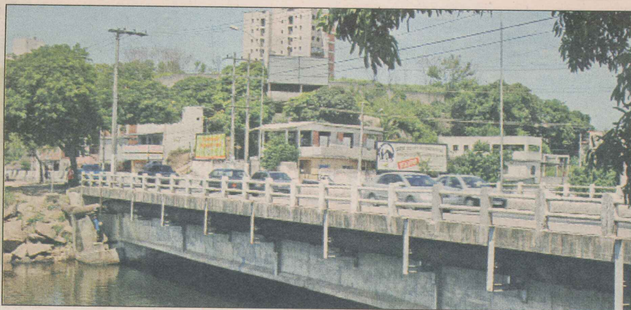
Tráfego de veículos na Ponte da Passagem
