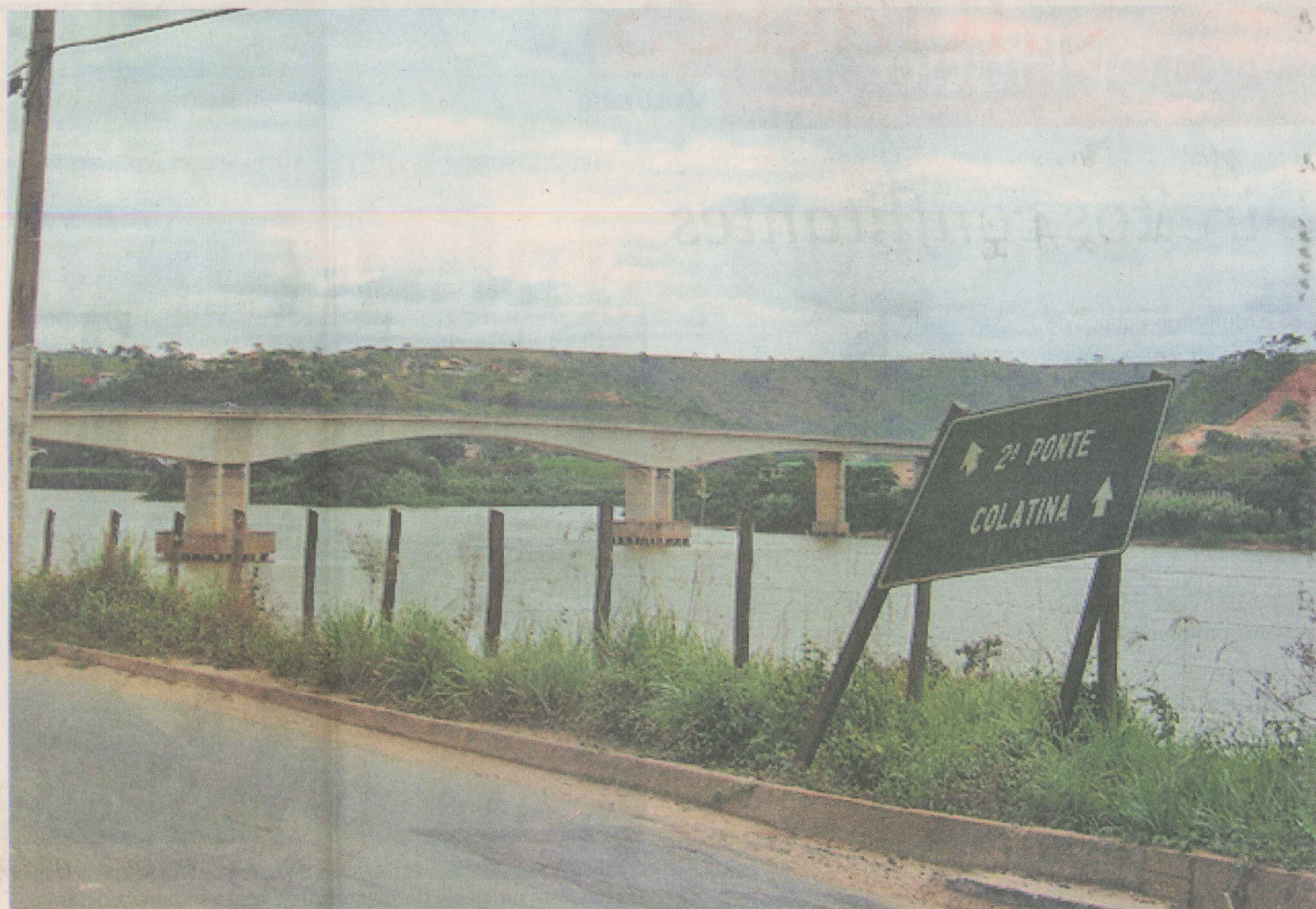
ESTRUTURA. A promessa é de que, além dos acessos à ponte, também seja construída a estrada do contorno de Colatina. FOTO: NILO TARDIN - ARQUIVO.
