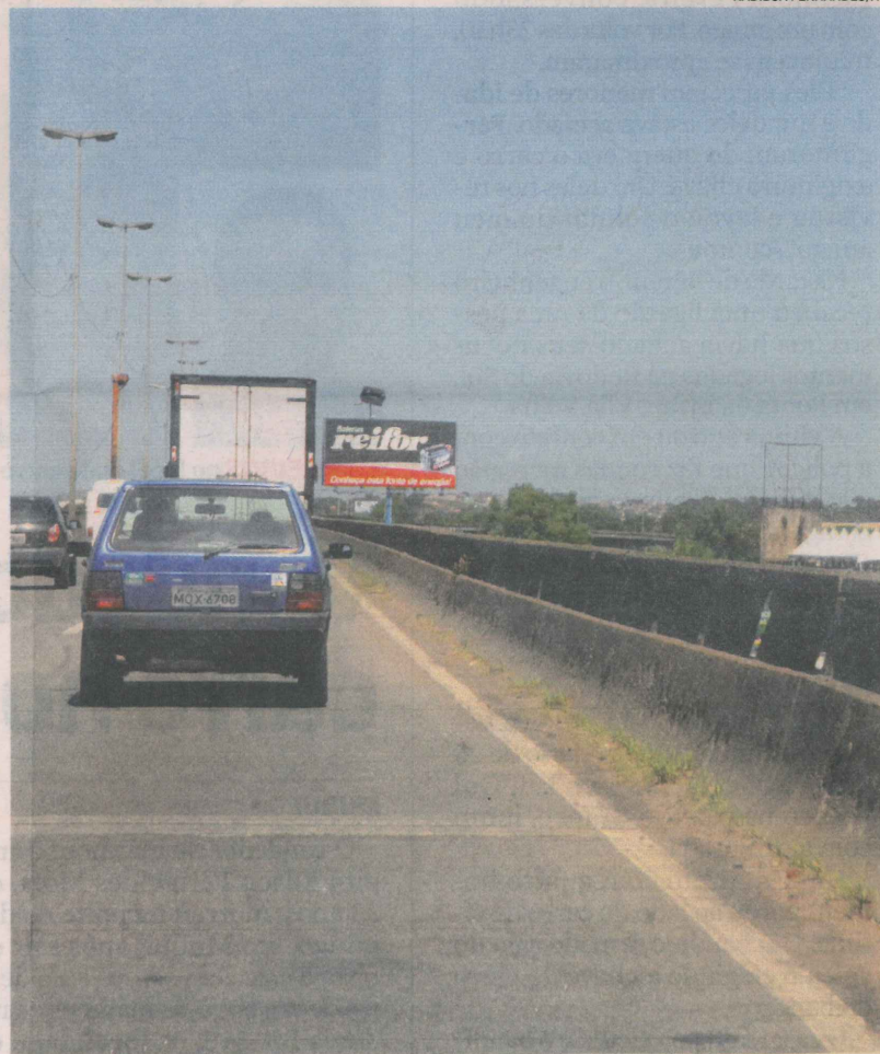
MATO CRESCE ÀS MARGENS das pistas da Ponte do Príncipe (2ª Ponte)
