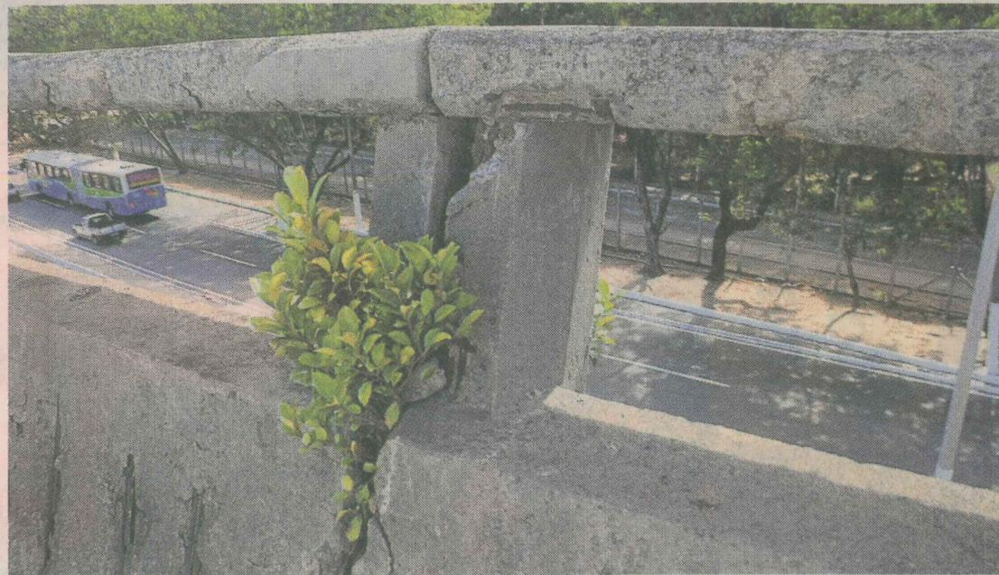
**PROBLEMAS.** Vergalhões expostos, com alguns pontos de “remendos”, uma enorme quantidade de trincas no concreto da via, além da falta de sinalização são alguns problemas constatados na ponte
