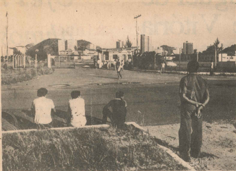
Alguns vão direto ao canteiro de obras
