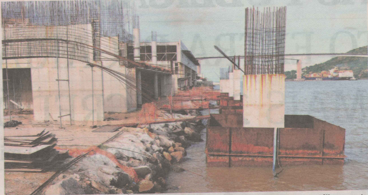
A nova empresa a ser contratada fará, entre outros serviços, recuperação da estrutura metálica exposta
