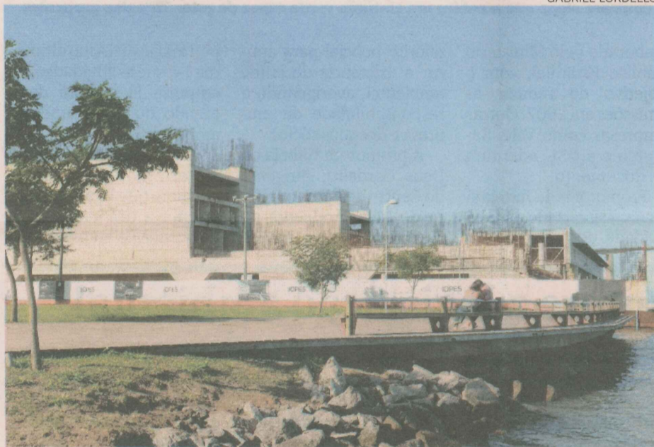
Os trabalhos no Cais das Artes serão retomados entre fevereiro e março de 2013
