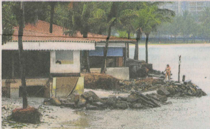
SEGURANÇA. Boias vão sinalizar a obra para embarcações
