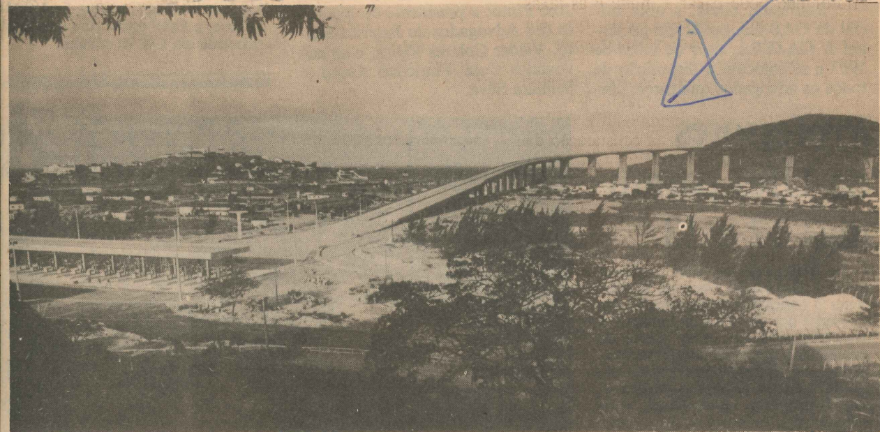
A Ceterpo está completando o trabalho de suspensão da estrutura metálica do vão central da ponte
