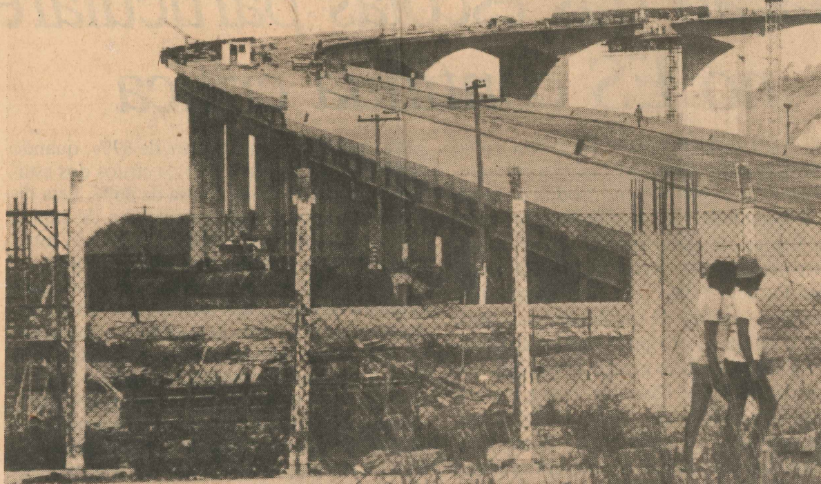
A parte metálica da obra da 3ª ponte, de responsabilidade da Usimec, atrasou os trabalhos
