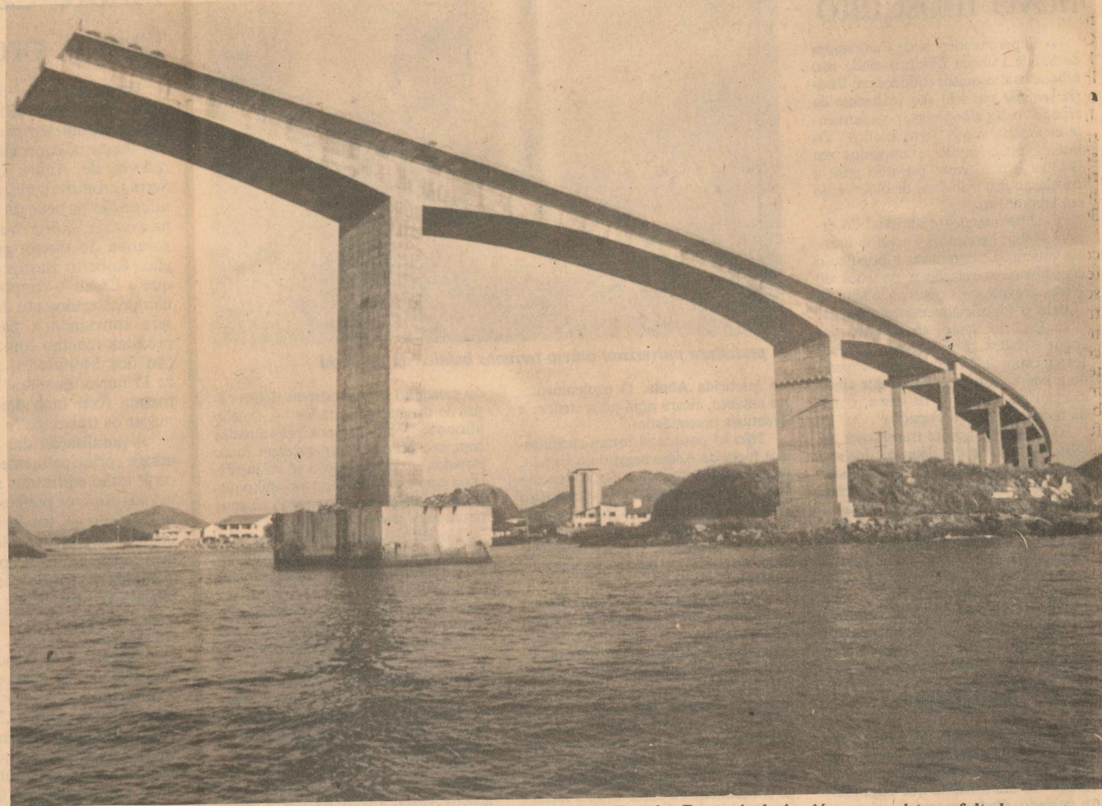
O governador José Moraes marcou para o dia 15 de fevereiro, a entrega da Terceira Ponte, inclusive já com as pistas asfaltadas
