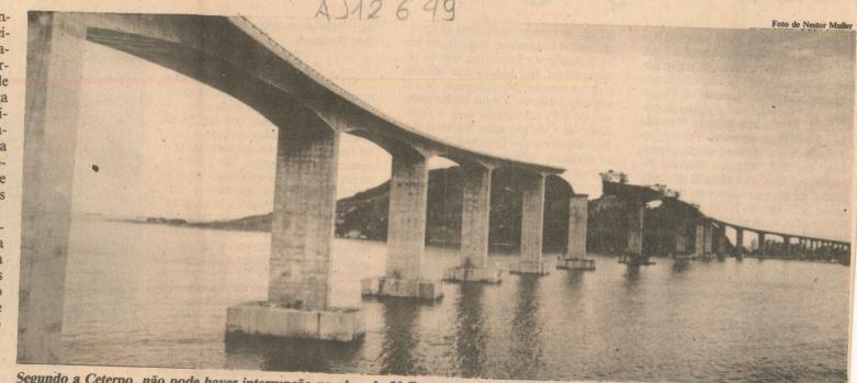
Segundo a Ceterpo, não pode haver interrupção na obra da 3º Ponte, pois as ligações em estrutura metálica têm que ser concluídas
