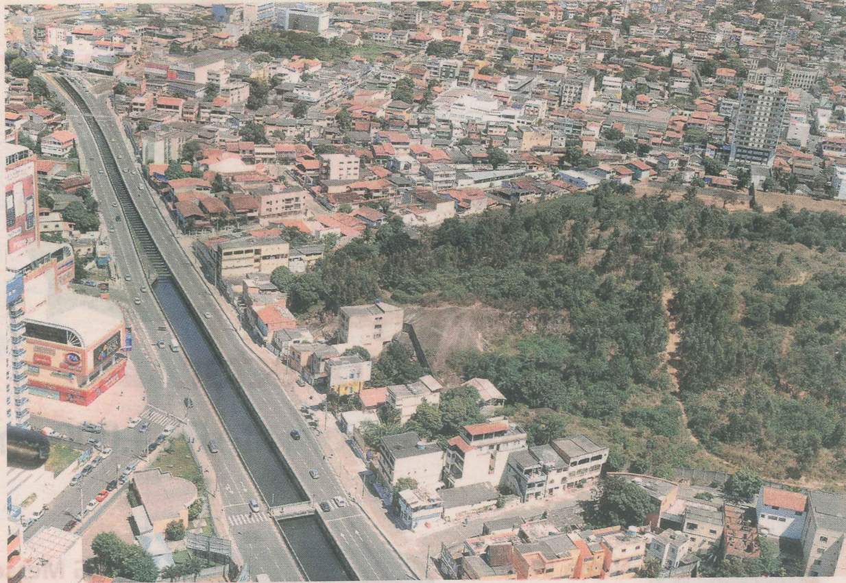
VISTA DO MORRO DO MARISTA, em Vila Velha, por onde vai passar viaduto que vai desafogar trânsito na região
