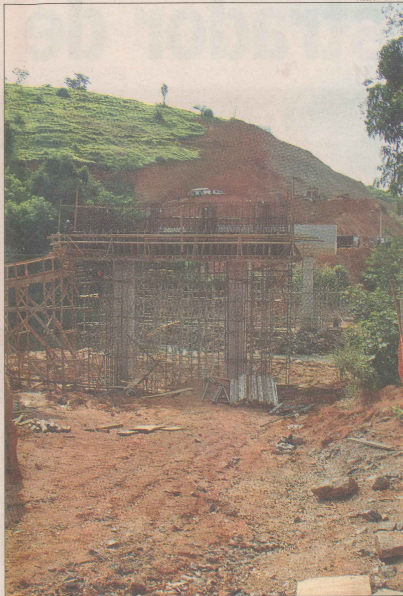
Construção da ponte: novo circuito será finalizado em agosto
