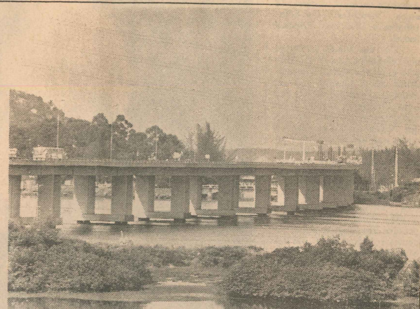
Recentemente concluída, a Ponte do Príncipe foi interditada duas vezes.
