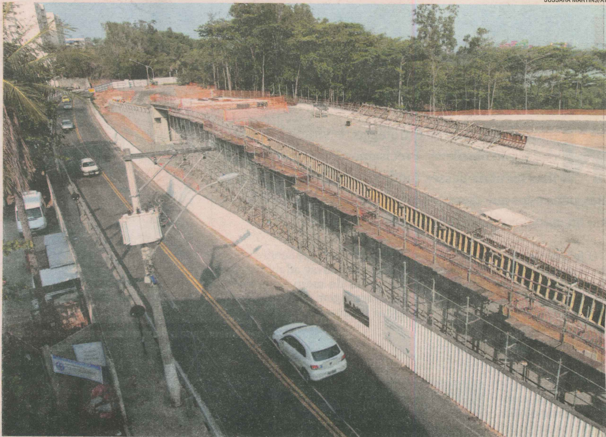
VIADUTO DE JARDIM CAMBURI está sendo feito em parceria entre a Prefeitura de Vitória e a Vale
